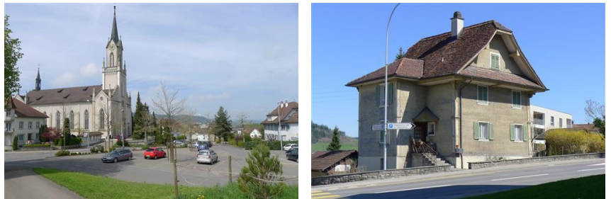
Abbildung 3: Baugruppe A «Kirchenbezirk» (links) und schützenswerte «Untere Kaplanei» mit Baujahr 1741 (rechts) | Quelle: Auszug aus dem Bauinventar des Kantons Luzern
