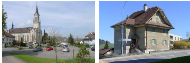
Abbildung 6: Baugruppe A «Kirchenbezirk» (links) und schützenswerte «Untere Kaplanei» mit Baujahr 1741 (rechts) | Quelle: Auszug aus dem Bauinventar des Kantons Luzern
