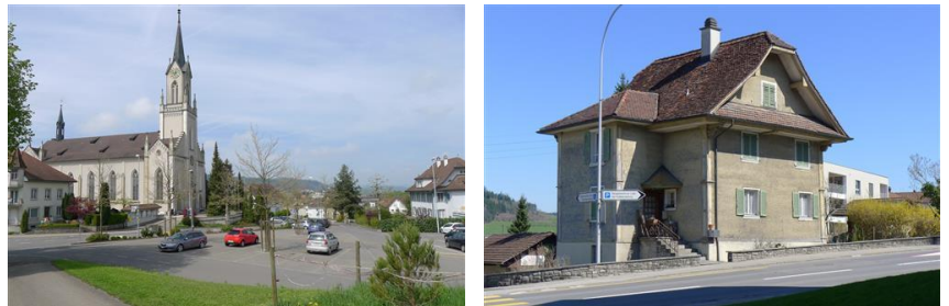
Abbildung 7: Baugruppe A «Kirchenbezirk» (links) und schützenswerte «Untere Kaplanei» mit Baujahr 1741 (rechts) | Quelle: Auszug aus dem Bauinventar des Kantons Luzern
