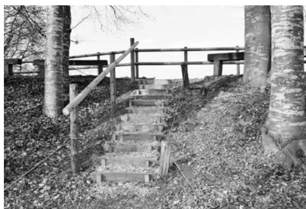
Neue Treppe und sicheres Geländer führen zur Kanzel.
