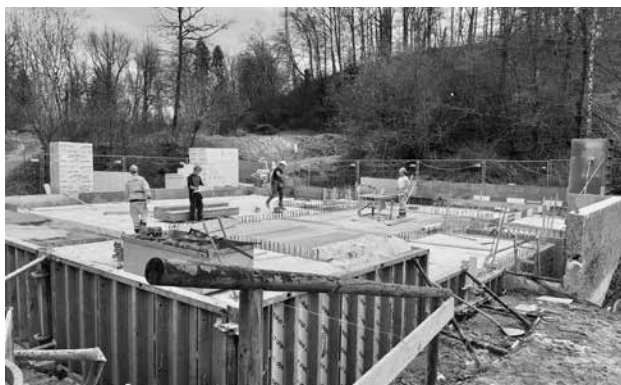
Auf solidem Grund baut sich gut. Die Bodenplatte des Erdgeschosses ist in Arbeit.
