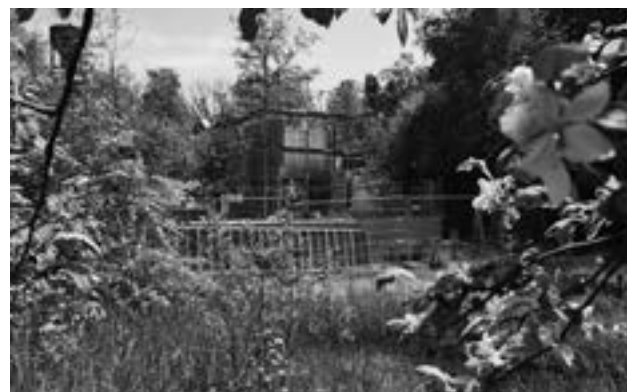
Deutlich wird der Turm des Neubaus erkennbar.
