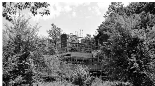
Der Bau des neuen Naturzentrums nimmt sichtlich Gestalt an.
