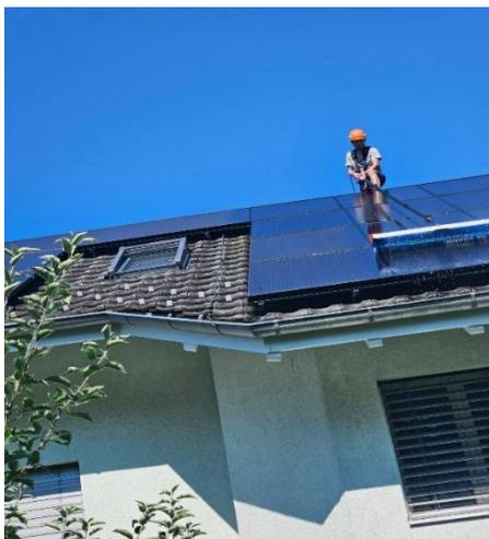
Abbildung 9 Reinigung der Solaranlagen
