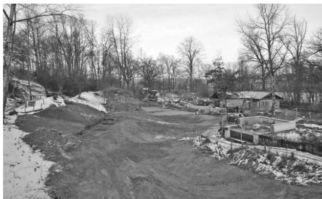
Der Aushub ist abgeschlossen und die Abdichtungsarbeiten stehen bevor (Stand 14. Januar 2026).
